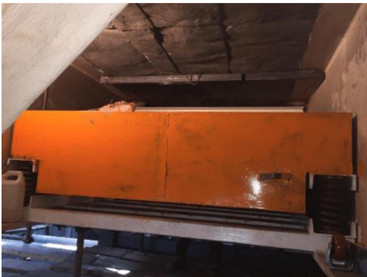
پروژه پایش سلامت و مقاوم سازی پل دسترسی مجموعه سایپا توسط میراگرهای جرمی - شهر یور ۹۵
