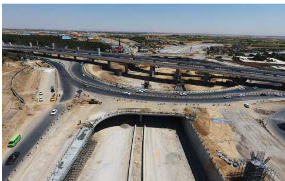
پروژه پل میدان استقلال - اسفند ۹۵
