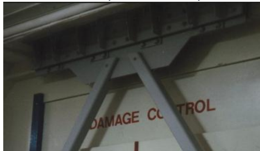
تصویر میراگر ویسکو - الاستیک
