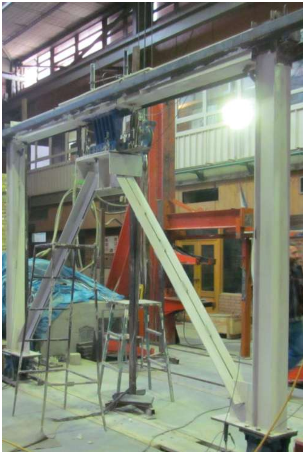
شکل شماره ۲- نصب میراگر TADAS بر روی قاب در آزمایش مرکز تحقیقات راه، مسکن و شهرسازی
