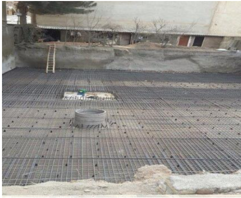
بتن ریزی پی
