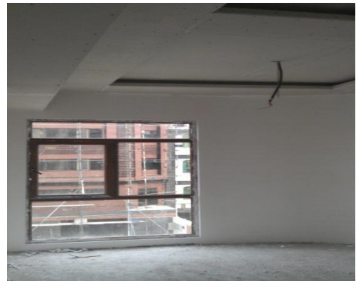
نصب قاب و شیشه پنجره ها
