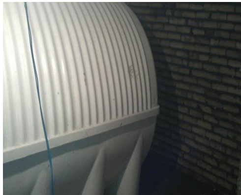
نصب مخزن آتش نشانی
