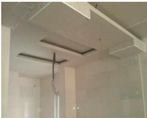
اتمام عملیات نصب کناف
