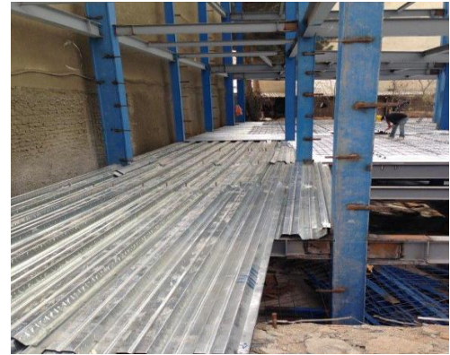
اجرای سیستم عرشه فولادی
