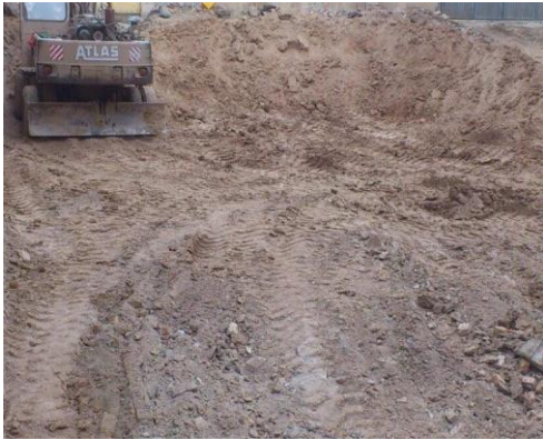
اجرای عملیات گود برداری.
