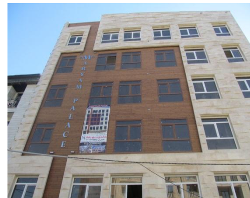
اتمام نمای اصلی ساختمان
