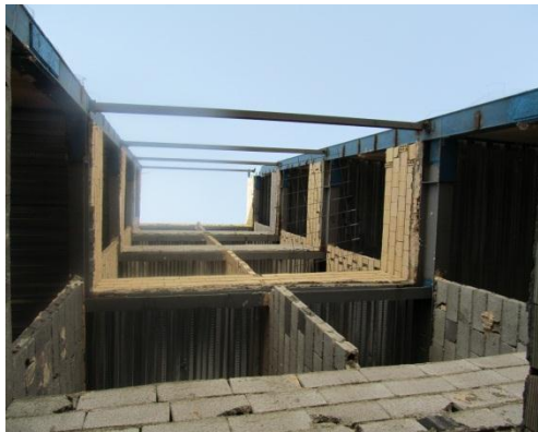
اجرای دیوار چینی و آجر چینی
