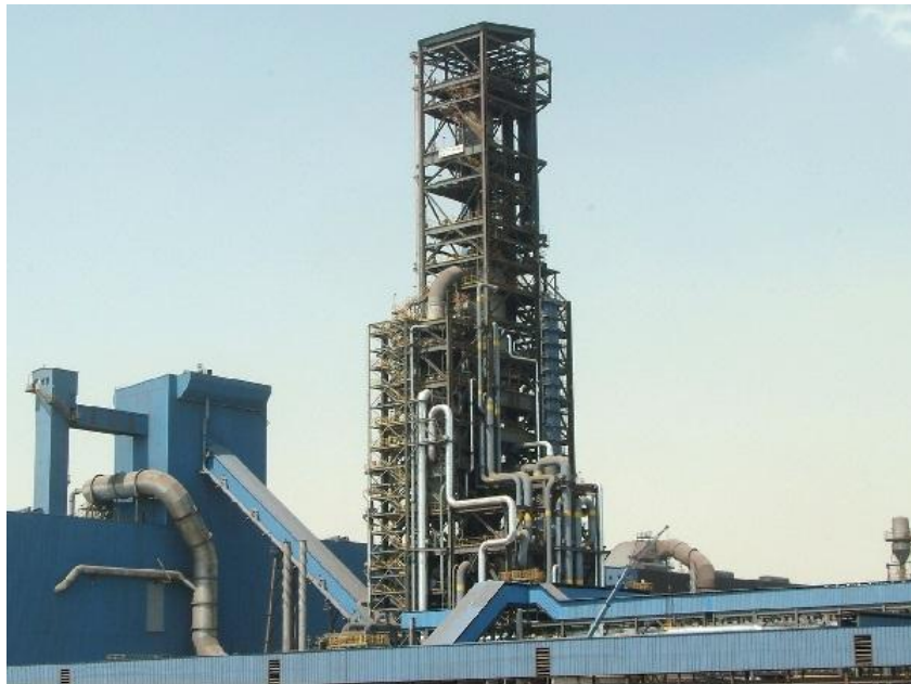
شکل شماره ۶ - شمای کلی سازه‌ی فلزی صنعتی با کارکرد احیای فلزات
