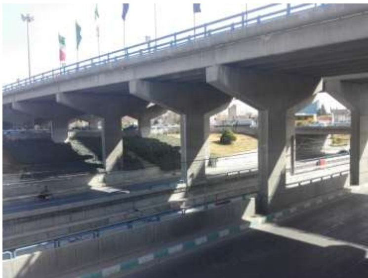
شکل شماره ۲: نمای جانبی پل چمران
