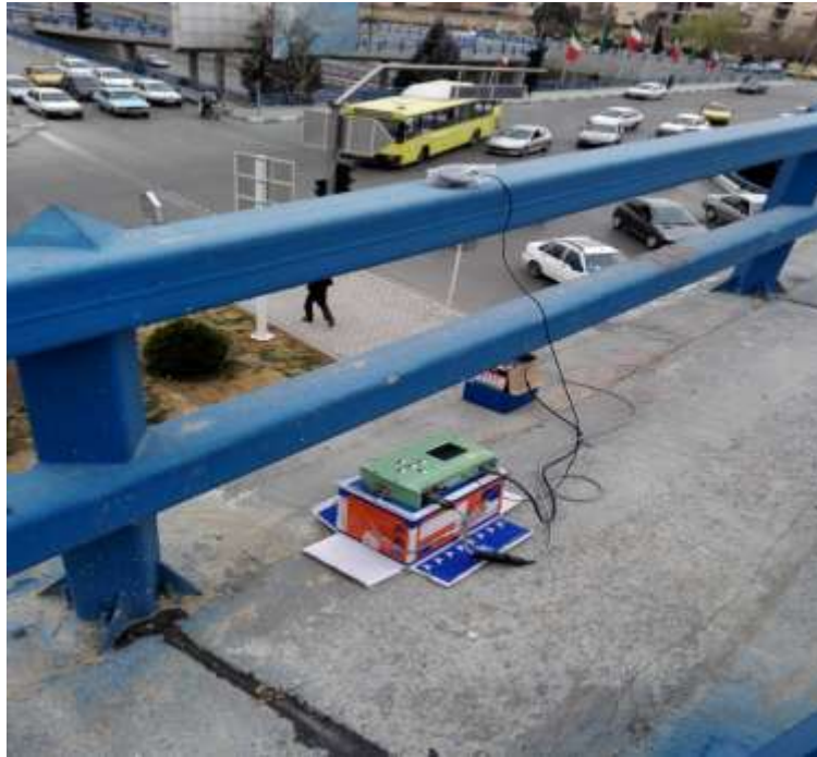
شکل شماره ۱۲: استقرار حسگر شتاب - پل چمران
