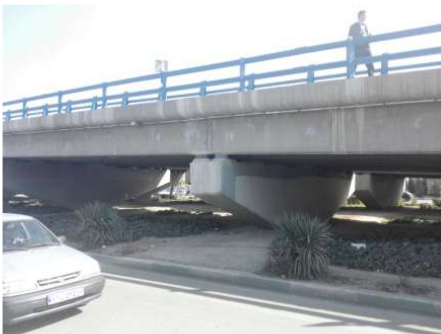
شکل شماره ۴: تصویری از پایه پل چمران
