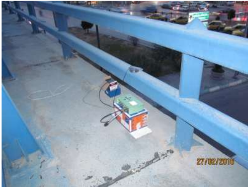
شکل شماره ۹: استقرار حسگر شتاب - پل چمران
