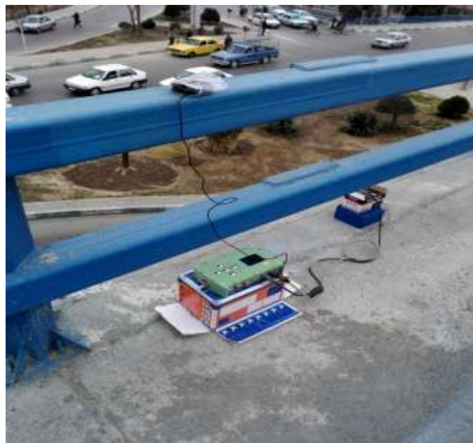
شکل شماره ۱۳: استقرار حسگر شتاب - پل چمران
