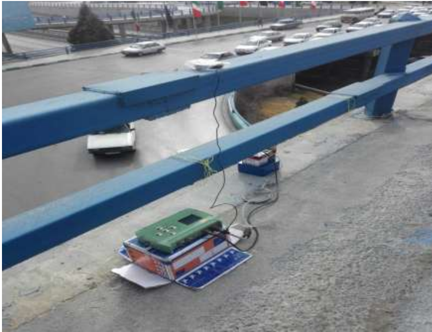
شکل شماره ۱۴: استقرار حسگر شتاب - پل چمران
