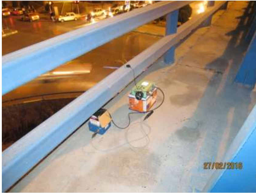
شکل شماره ۱۰: استقرار حسگر شتاب - پل چمران
