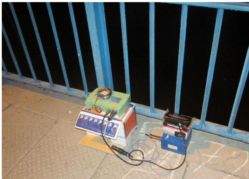
شکل شماره ۱۹: استقرار حسگر شتاب ۱ (آزمایش ۱۰) - پل فلزی
