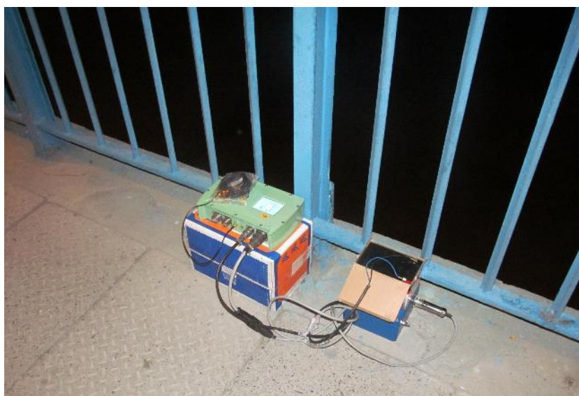
شکل شماره ۲۰: استقرار حسگر شتاب ۵ (آزمایش ۱۰) - پل فلزی
