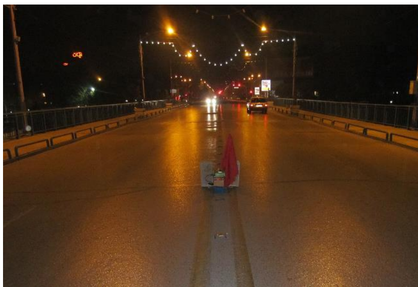
شکل شماره ۲۵: استقرار حسگر شتاب ۳ (آزمایش ۱۳) - پل فلزی
