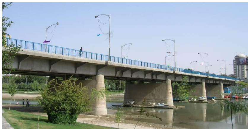
شکل شماره ۲: نمای جانبی پل فلزی از سمت شرق پل - پل فلزی
