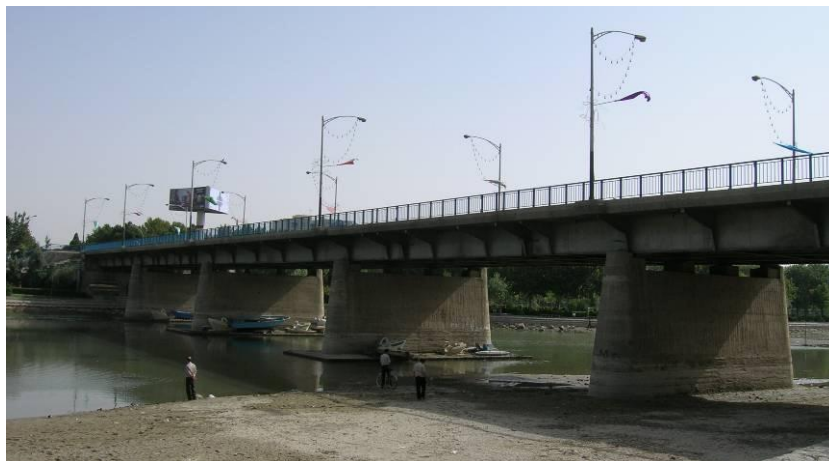
شکل شماره ۳: نمای جانبی پل فلزی از سمت غرب پل - پل فلزی
