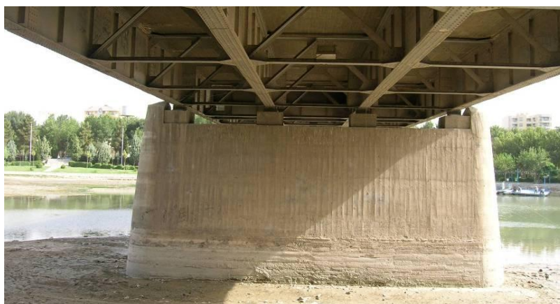
شکل شماره ۶-تصویری از پایه پل فلزی- پل فلزی
