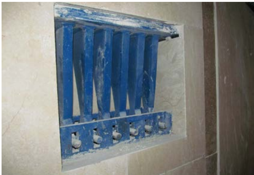
شکل شماره ۶- میراگر تدس نصب شده در سازه، توسط گروه تخصصی صنعت و علم
